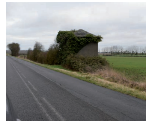
Photographie 97 : Bâtiment abandonné sur la RD 65.
